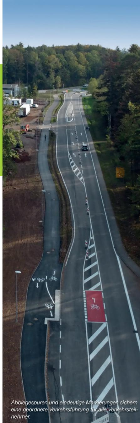
Abbiegespuren und eindeutige Markierungen sichern eine geordnete Verkehrsführung für alle Verkehrsteilnehmer.
