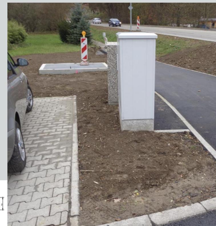
Die neue Anlage: vorne der Schaltschrank, dahinter die Gebläsestation, im Hintergrund der Geschiebeschacht.
