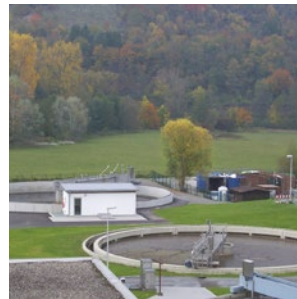
Regen- und Abwasser- behandlung
