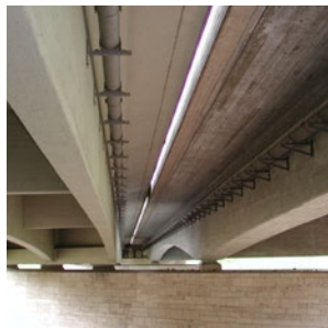
Bauwerksprüfung und Instandsetzung
