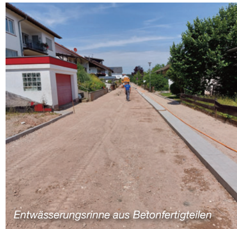
Erneuerung des Kanals auf gesamter Länge
