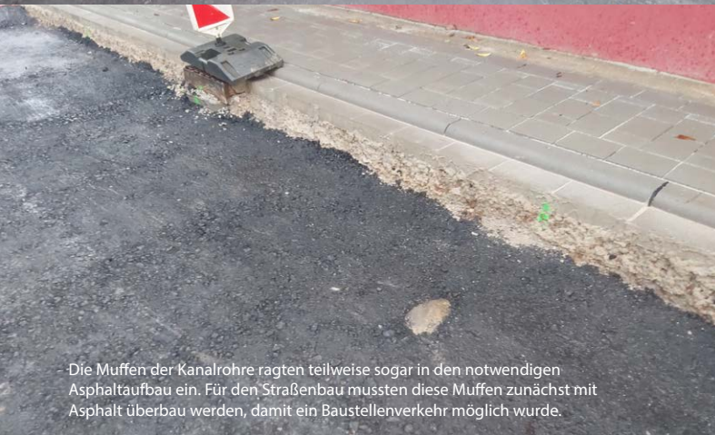
In Teilbereichen mit besonders hoch liegenden Leitungen und Kanälen wurde die Schottertragschicht reduziert und dafür die Stärke der Asphalttragschicht erhöht.
