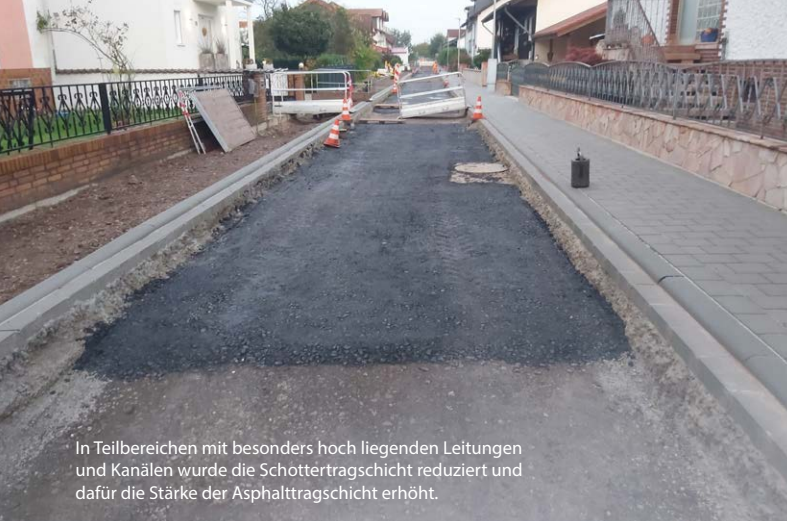
In der Kreuzung Am Junkergarten – Weyrichstraße wurde die Schachtdecke erneuert. Auch hier ist gut zu erkennen, dass die Kanalrohre ungewöhnlich hoch liegen.
