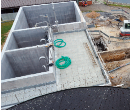
Hinten im Bild der Schlammstilo, davor der Voreindicker, vorne der Nacheindicker
