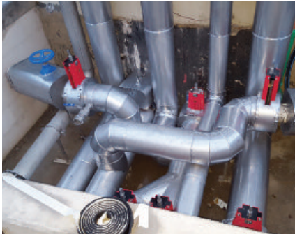
Beschickung des Faulturms
