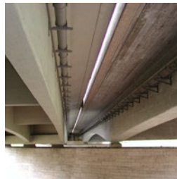
Bauwerksprüfung und Instandsetzung
