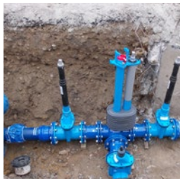
Gas-, Wasser- und Nahwärmeversorgung
